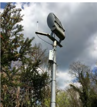
Erstes Gateway auf der Westseite des Schlossberges
