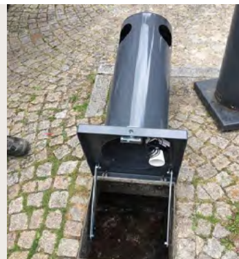
Höheres Fassungsvermögen dank Behälter unter der Erde (mit Sensor ausgestattet)
